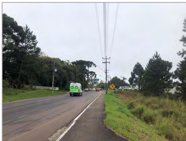
2. Rod. do Caqui, sentido centro, imóvel à direita.
