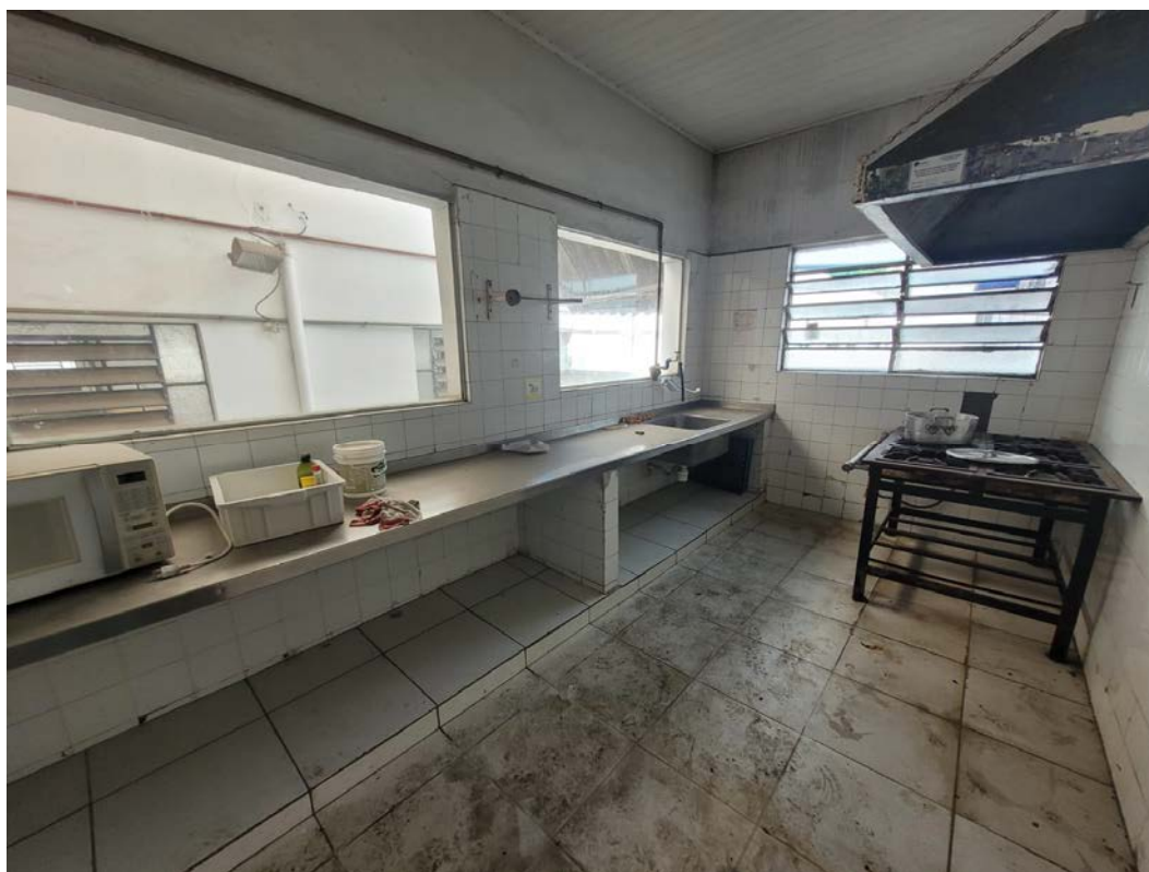
Fotografia 19 - Aspecto interno da Edificação nº 04 – Estoque / Refeitório.
