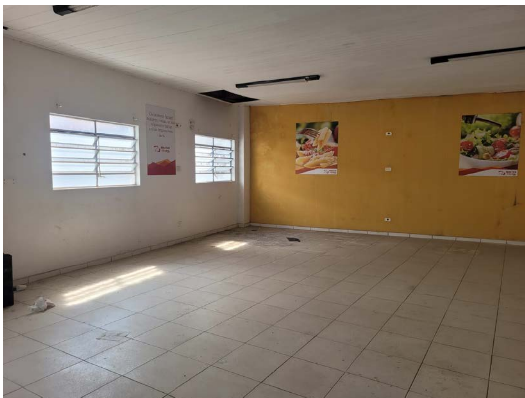
Fotografia 18 – Aspecto interno da Edificação nº 04 – Estoque / Refeitório.
