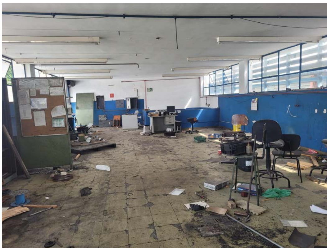
Fotografia 17 – Aspecto interno da Edificação nº 03 – Manutenção.
