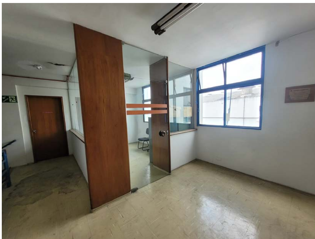
Fotografia 14 – Aspecto interno da Edificação nº 01 – Administração.
