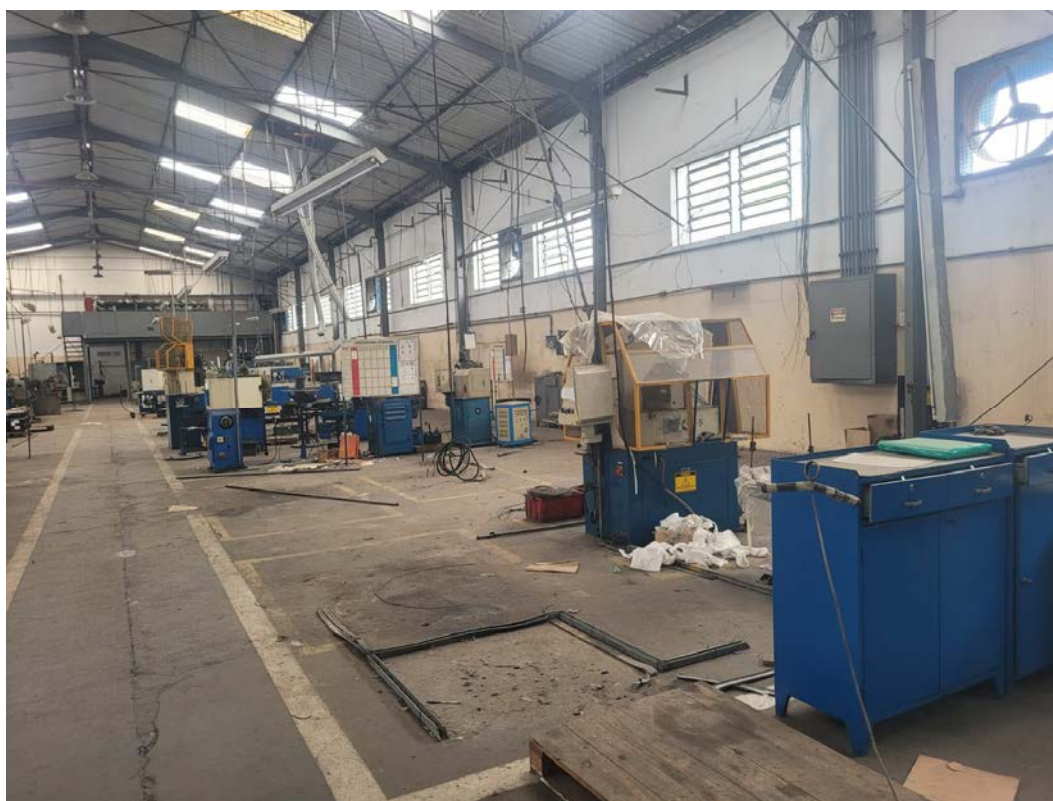
Fotografia 12 – Aspecto interno da Edificação nº 02 – Galpão / Fábrica.
