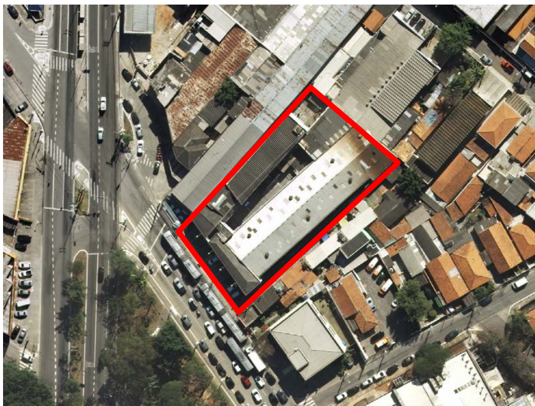
Fotografia 01 – Aspecto geral do imóvel avaliado (limites em vermelho).
