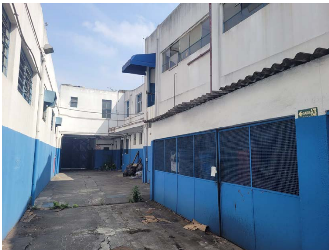
Fotografia 10 – Aspecto externo das edificações existentes no imóvel avaliado.
